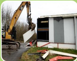
Réalisation de notre premier éco-chantier territorial dans le cadre de la déconstruction sélective du garage mécanique de Labeuvrière
