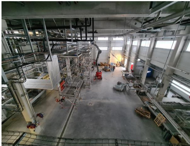
Images du rez-de-chaussée
