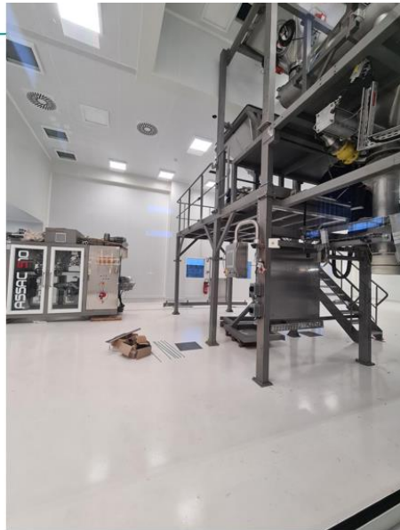
Images de la salle conditionnement
