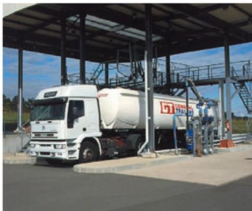
L'aire de déchargement et chargement d'un camion citerne doit être capable de recueillir les égouttures, voire les éventuelles fuites.
