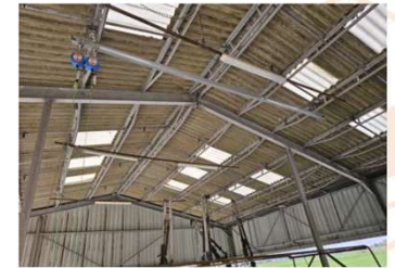
Photos des équipements installés
