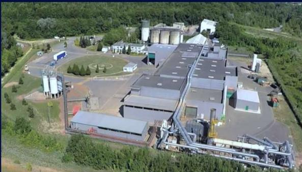
SCORI Hersin est notre plateforme de prétraitement spécialisée dans la fabrication de combustible solide de substitution (CSS via broyage et imprégnation de déchets pâteux sur un support absorbant neutre : La sciure de bois).
